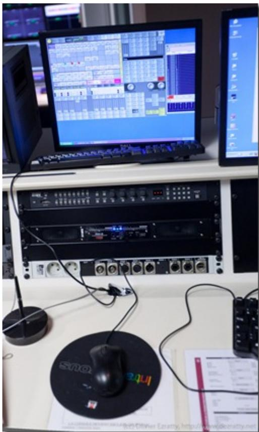
Le pilotage des caméras comprend deux parties : la commande des caméras à distance (pour la focale et la mise au point, les **Sony** sont pilotées par un HD Camera Control Unit HDCU1500) et la commande de leur position pour celles qui sont motorisées.
