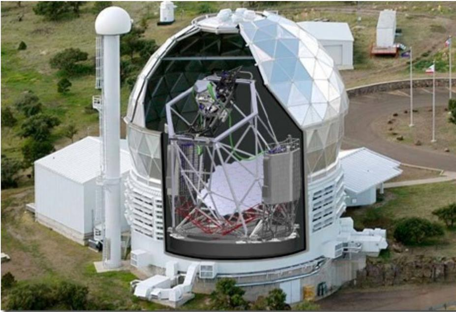
Le miroir secondaire et ses instruments est mobile, permettant le suivi d'objets célestes en déplacement. Une partie des instruments a été mise à jour au début des années 2000. Je vous passe les détails !
