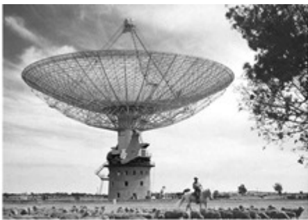
radiotélescope Parkes à ses débuts gros maillage, grandes longueurs d'ondes
